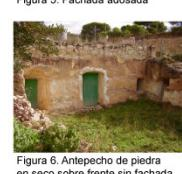
Figura 6. Antepecho de piedra en seco sobre frente sin fachada
